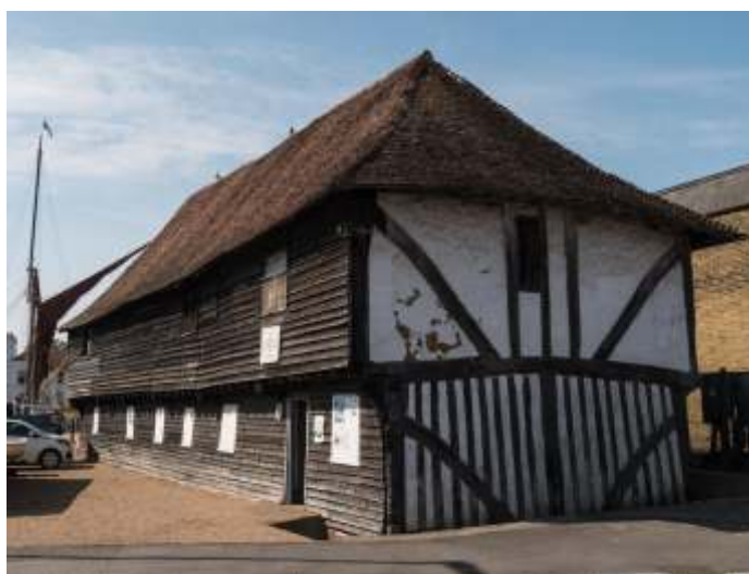
TS Hazard in Conduit Street
